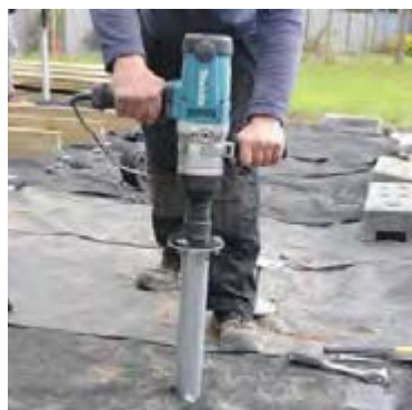
Adapterplatte mit Konnektor 41 mm für die Verwendung eines Schlag- schraubers mit einer Mindestleistung von 1000 W
